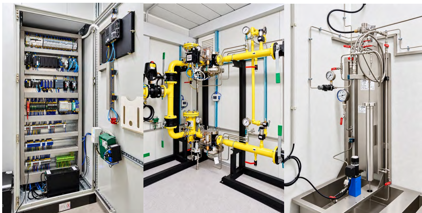
Fabricación e integración de módulos y equipos.
