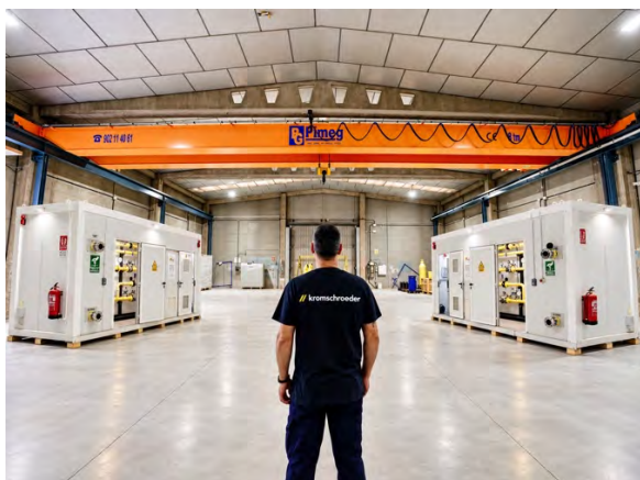
Preparación y logística de módulos completos.
